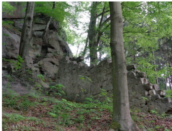
Alte Mauerreste am Bärengarten
