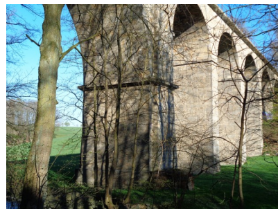
Viadukt der alten Bahnlinie nach Arnsdorf
