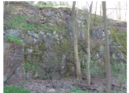
Felswand am Viadukt
